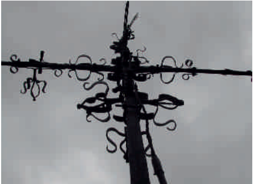
Ornamenten gaan verloren door roest
