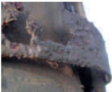
IJzeren ring bijna doorgeroest
